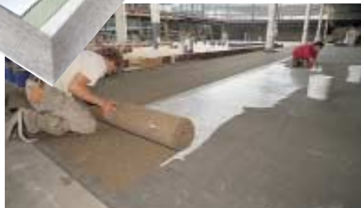
На выравненный и сухой бетонный пол клеем CascoProff Extra 3444 наклеивается звукоизолирующая резиновая пробка
