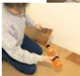
Склеивание ламельного паркета соединением шипом с помощью клея Silva Aqua 3337
