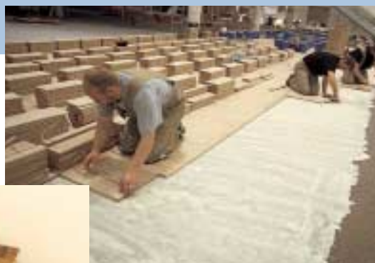
Склеивание ламельного паркета соединением шипом с помощью клея Silva Aqua 3337
